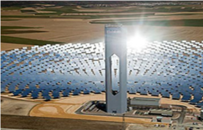
Foto Web: Usina Fotovoltaica
